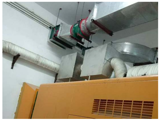
备用发电机尾气处理
