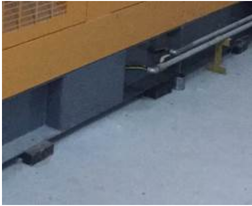
备用发电机设备减震
