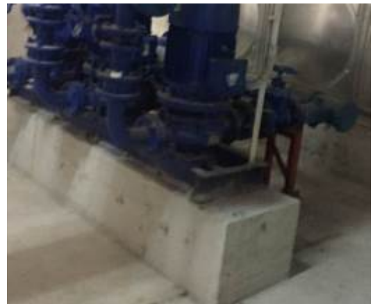
项目水泵减震
